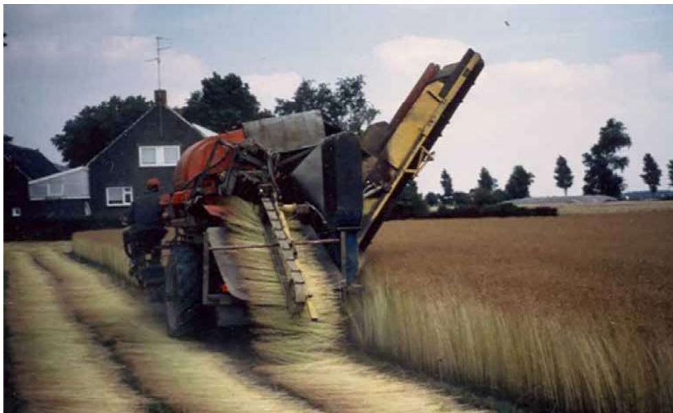
De vlasplukker-ontzader, eerste versie (smal, 1986). De onderbouw was een Union voorplukker, de opbouw kwam van een Russische vlasplukker-ontzader op basis van het kammen-systeem. Deze had Van der Bilt naar Nederland gehaald. Met die levering kwam ook een Rus mee. Die hield goed in de gaten wat Nederland met de Russische apparatuur deed
