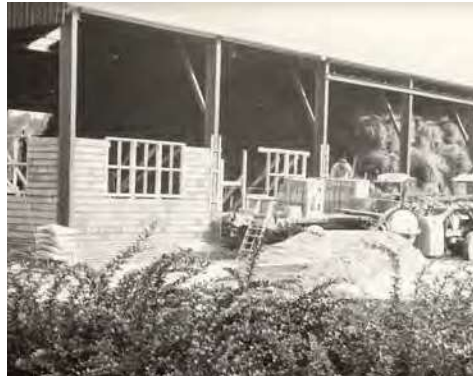
Een week na de sloop staat de nieuwe loods overeind
